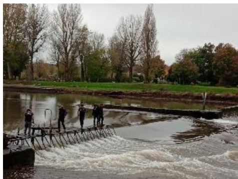
© NEC – Abaissement Bléré
